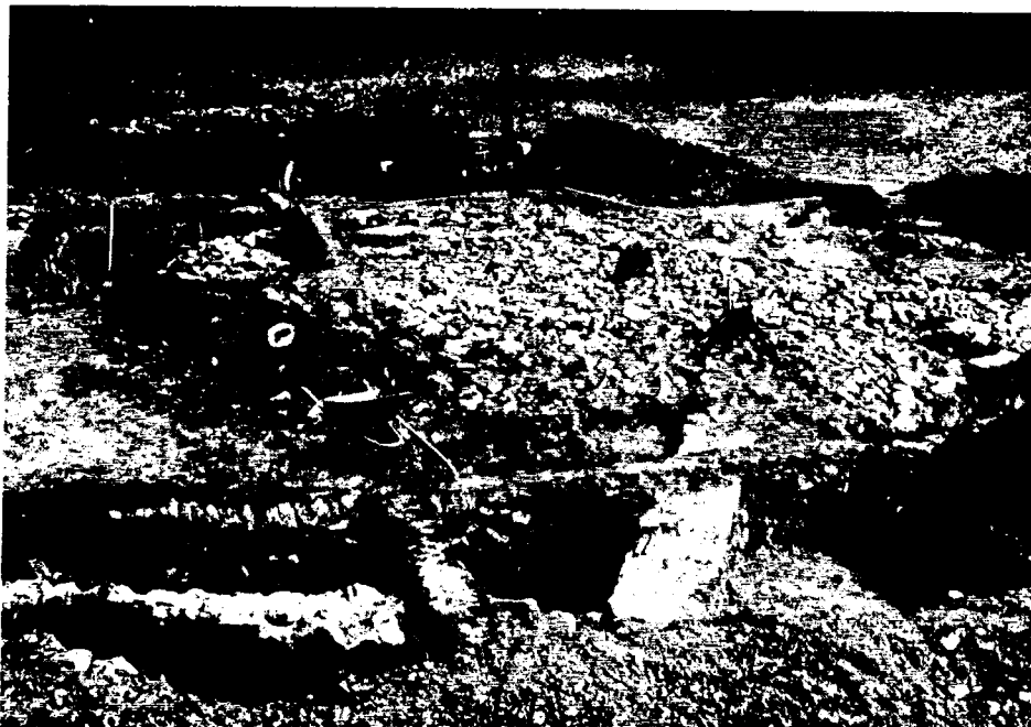
Подна супструкција цркве-брвнаре из 18. века
